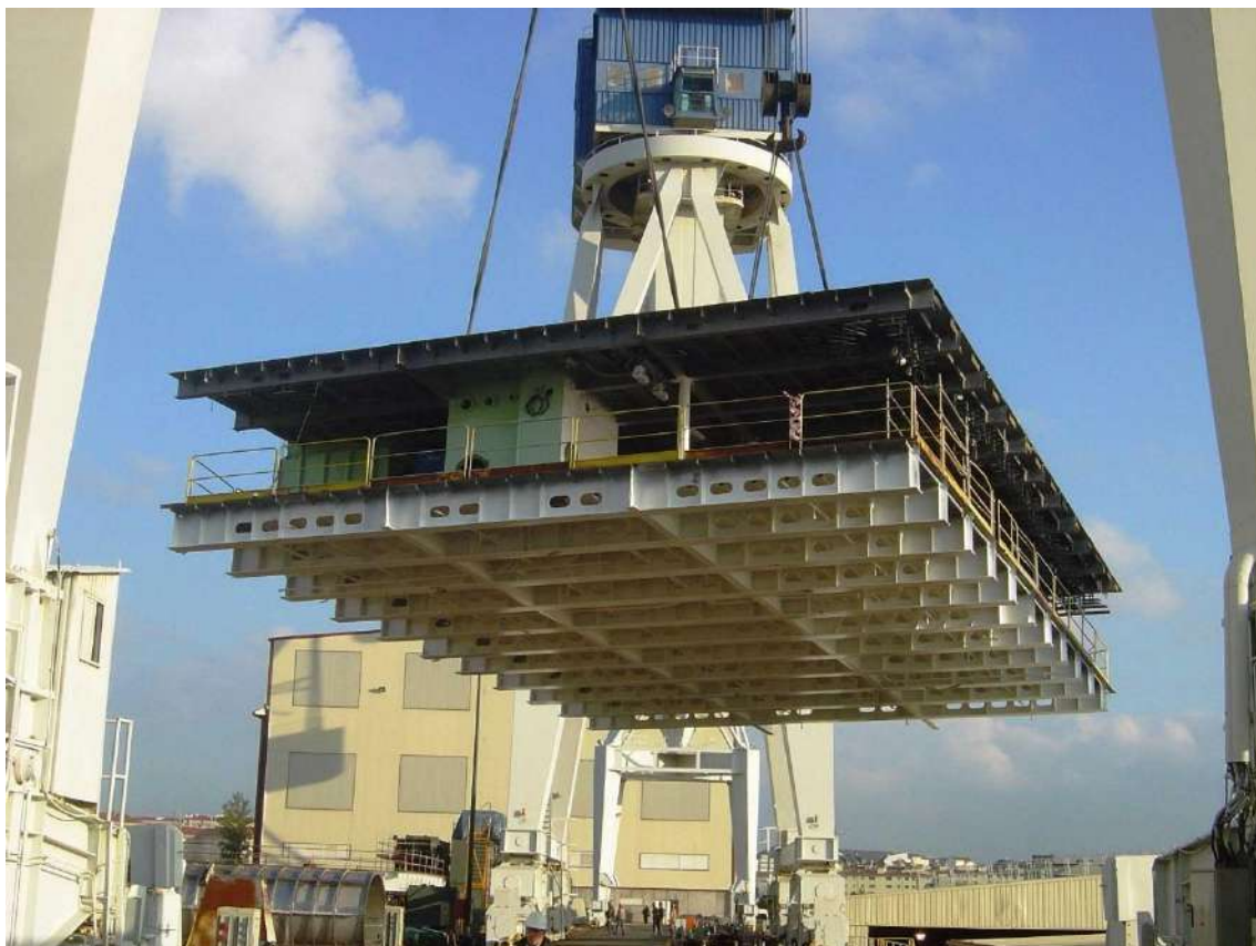
Secuencia de elevación de un bloque (Imagen facilitada por el autor)
