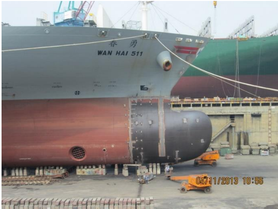
Retrofit del bulbo de un portacontenedores.
