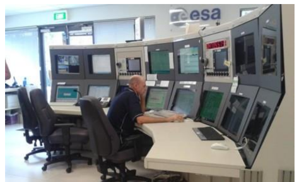
Centro de Control de New Norcia (ESA)
