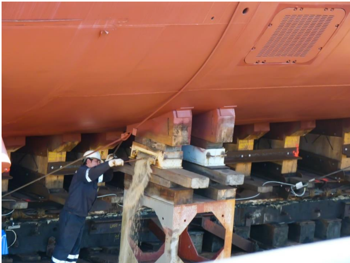
Figura 2: Operario actuando en caja de arena
