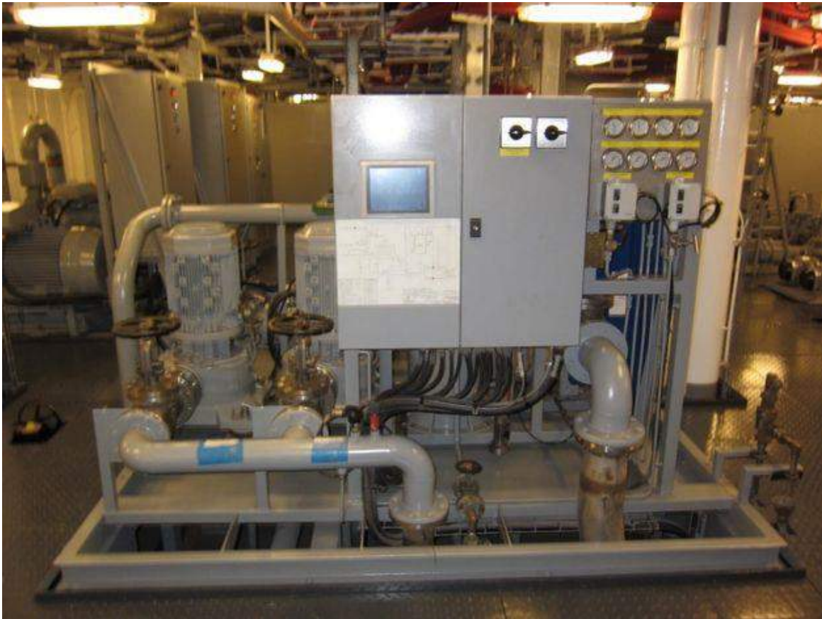
Figura 3: Polín de apoyo de un equipo
